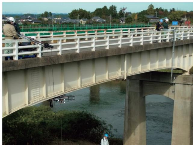
図8 試験の様子(橋梁脱着型マルチコプタ)
