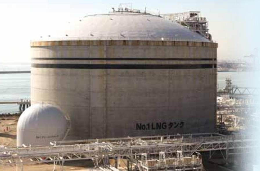
仙台火力発電所(東北電力(株))に建設された地上式PC-LNGタンク(容量:16万 m<sup>3</sup>) (左)、覆土式LNG地下タンク(東京ガス(株)、容量:25万 m<sup>3</sup>)の内部(右)。(資料提供:(株)IHI)
