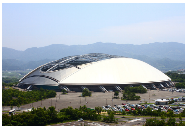
図13 大分銀行ドームの外観写真 (2016年6月撮影, 銀色部分がチタン製屋根)
