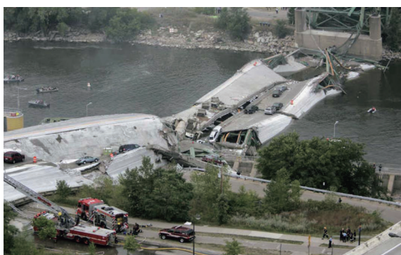
写真1 米国・I-39W高速道路橋崩落事故
