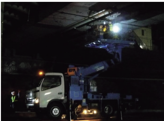
写真2 跨線橋点検状況
