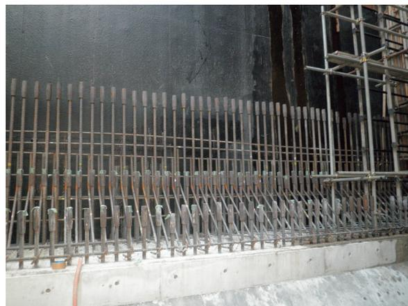
写真4 地下構造物への機械式継手の適用例 (土木)
