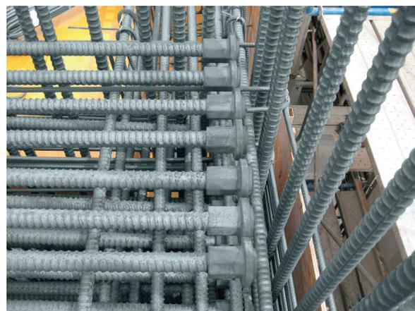
写真5 柱梁接合部への定着板の適用例 (建築)
