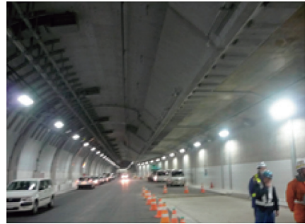
写真10 切開き部の完成状況
