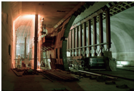
写真9 切開き部の仮設支保工
