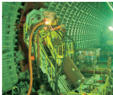
発進部施工状況
