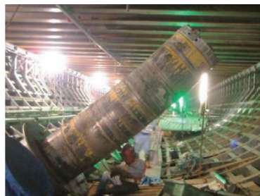
到達部施工状況
