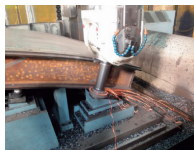
写真7 5面切削機による高精度の寸法確保
