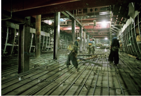
写真8 切開き部の鋼殻接続部配筋
