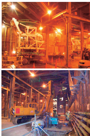
写真14 鋼製連壁施工状況（左：掘削、右：建込み）
