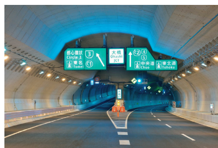
写真12 大橋連結路完成状況(下層：分岐部)
