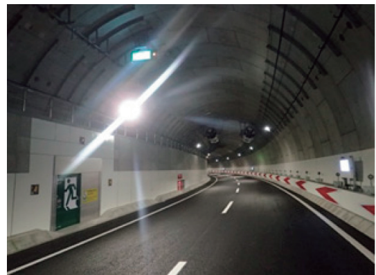
写真4 SBLセグメントによる躯体完成状況
