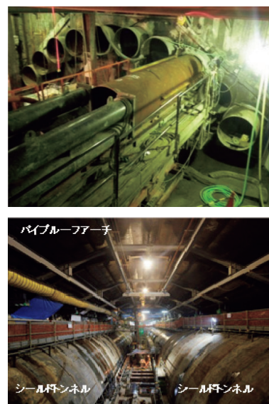
写真18 パイプルーフアーチ工法を適用した施工状況
