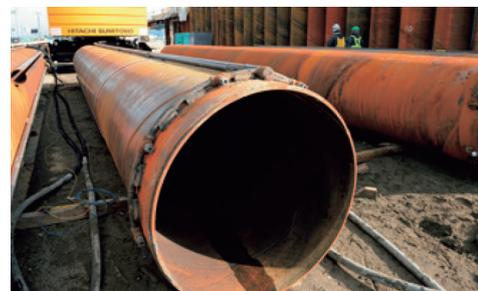
図6 ウォータージェット噴射ノズル付き鋼管矢板
