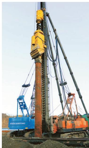
図2 中掘り工法による鋼管杭施工状況
