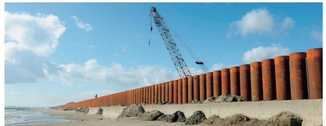
図5 打設済み鋼管矢板壁
