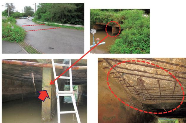
中柱がせん断破壊? 床版主鉄筋も破断!
