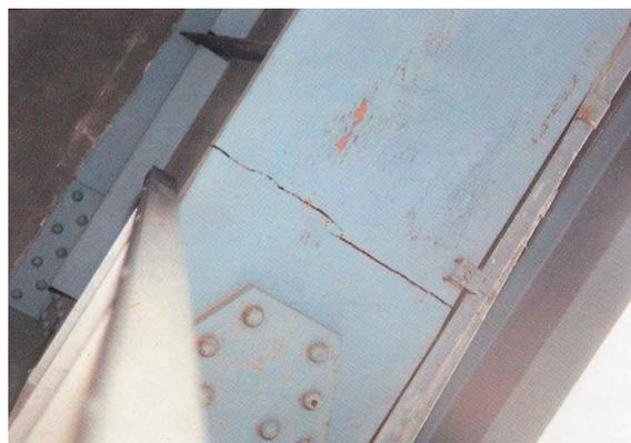
写真16 主桁グループ溶接部に発生した疲労き裂
