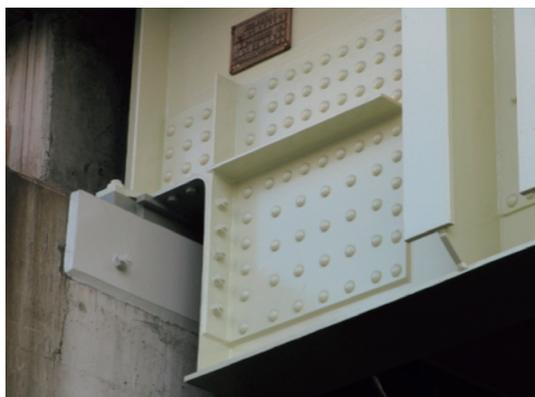
写真19 添接板を使った切り欠き部補強事例
