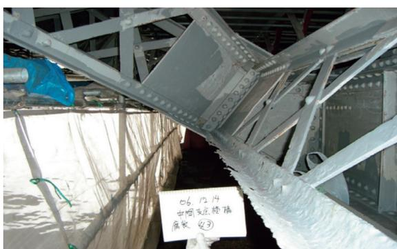
写真10 部材が輻輳する桁下の主構造
