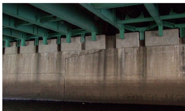
写真11 耐震補強によって支承部分の点検が困難となった状況
