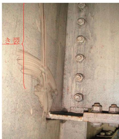
写真15 主桁ウェブに進展した疲労き裂
