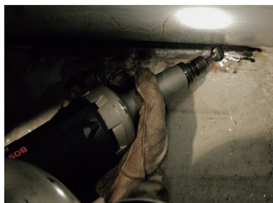
写真18 棒グラインダーによるき裂切削状況
