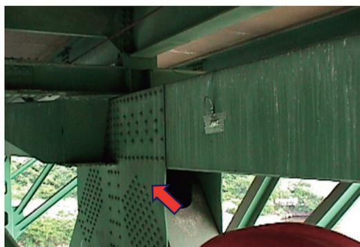
写真1 I-39W橋のガセットプレート(崩落前)
