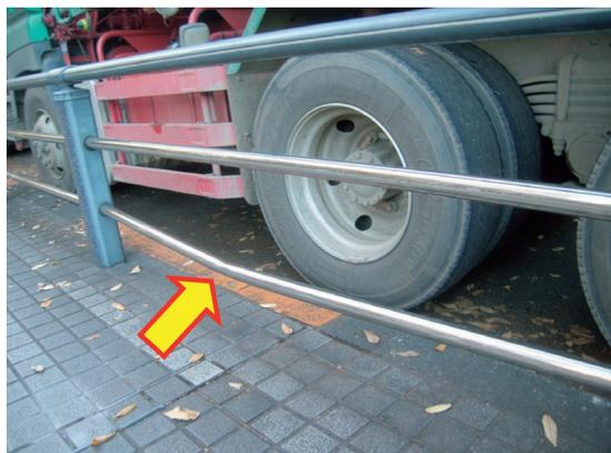
写真9 変形した横断抑止柵
