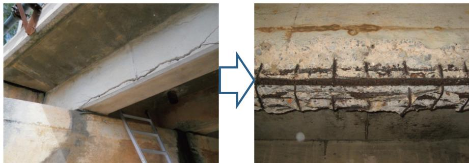
写真23 塩害によるひび割れが鉄筋破断となった事例
