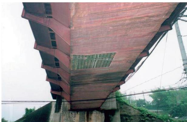
写真20 車両の衝突で変形した主桁を補修した事例
