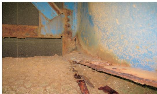
写真8 日々の清掃を怠ったことによる主桁の断面欠損状況
