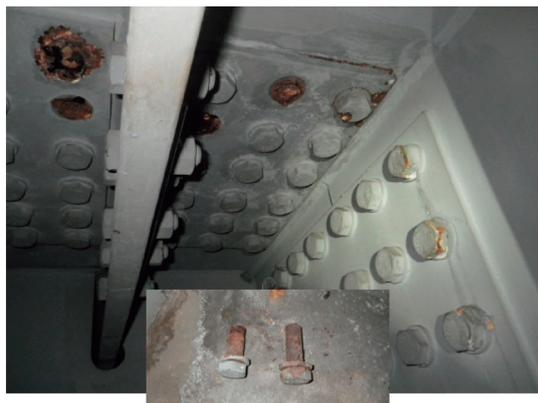
写真21 遅れ破壊現象による高力ボルトの脱落事例
