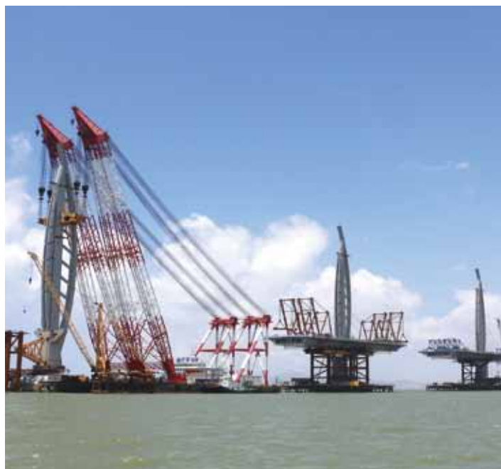
斜張橋部に直径7 mm、引張強度1870 MPa級の日本製橋梁ケーブル用線材が採用された。 (写真提供:新日鐵住金(株))
