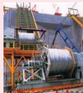
PWS工法は、事前に工場で亜鉛めっき鋼線を束ねてストランドとし、リール巻きた状態で輸送し、現地で引き出す。
