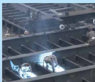
カーデッキブロックの溶接
