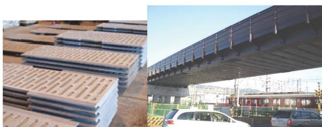
写真5 埋設型枠としての鉄道構造物への適用 (本設利用)<sup>3)</sup>
