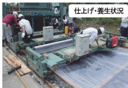
写真15 材料の敷設状況（施工実験）
