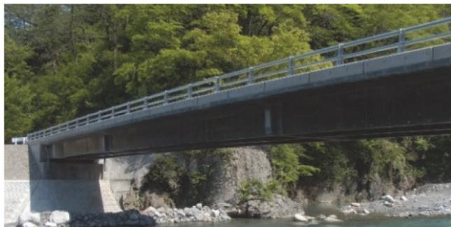
写真13 AFt系UFCの場所打ち施工で構築された道路橋<sup>6)</sup>
