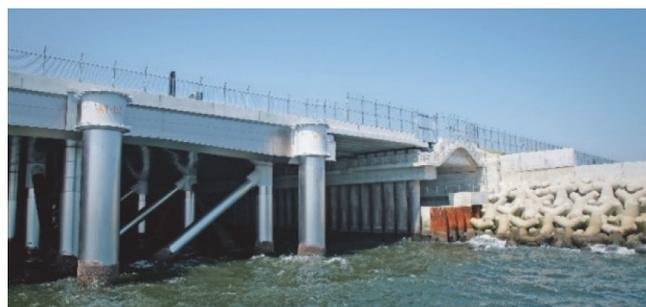
写真10 東京国際空港D滑走路棧橋部（ジャケッ式棧橋）<sup>5)</sup>
