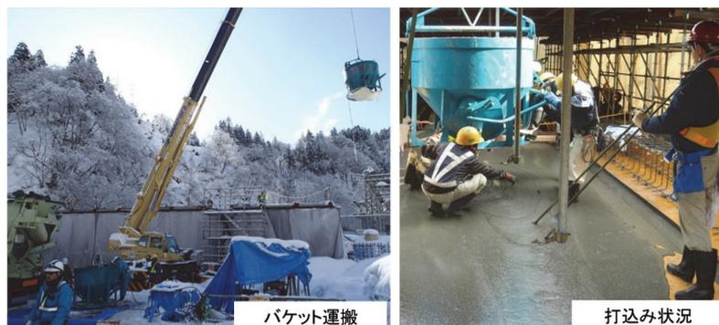
写真14 AFt系UFCの運搬・打込み状況<sup>6)</sup>
