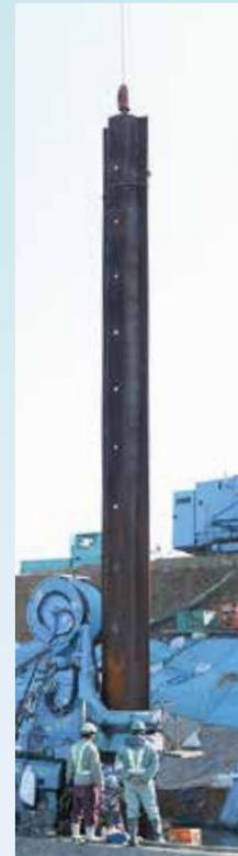
鋼矢板上部に透水孔を有するハット形鋼矢板
