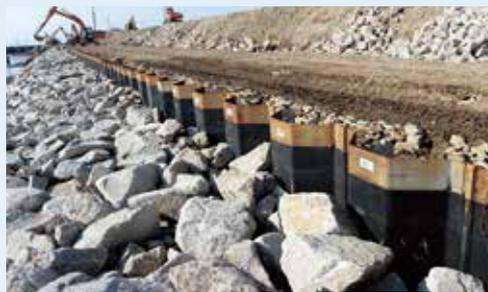
重防食仕様の鋼矢板打設完了状況
