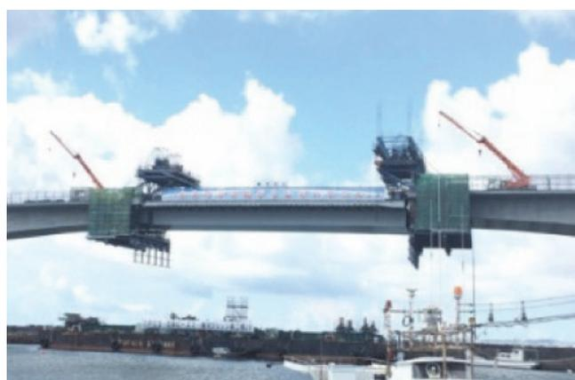
図6 「牧港高架橋」鋼橋部一括架設状況写真
