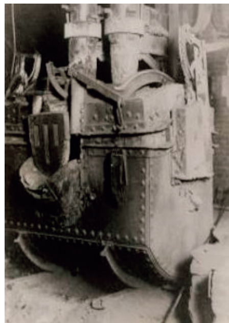
写真2 現存するわが国最古の1.5tエル式アーク炉
