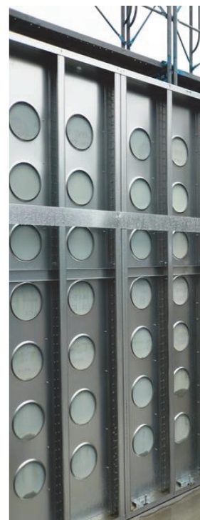
図11 バーリング孔付き耐力壁 （写真提供：NS ハイパーツ株式会社）
