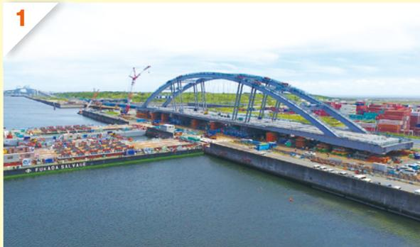
1 自在に方向を変えることができる巨大な多軸式特殊台車を、水路脇で地組された鋼桁の下に滑り込ませ、引き出すように台船の上に移動させる。
