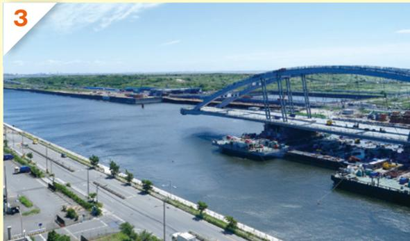
3 鋼桁を、組立ヤードから東へ400m離れた架設ポイントまで運ぶ。
