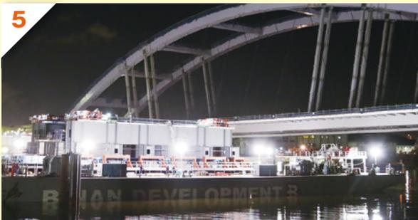
潮位の変化に合わせて大型台船のバラスト水を調整して台船を退出させ、油圧ジャッキとサンドル（井桁上に組んだ支台）を用いて鋼桁をゆっくりと降下させた。
