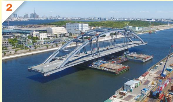
2 鋼桁を大型台船に載せる(ロールオン)。
