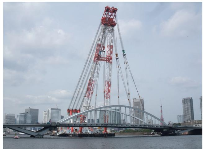
写真3 築地大橋での大ブロック一括架設
