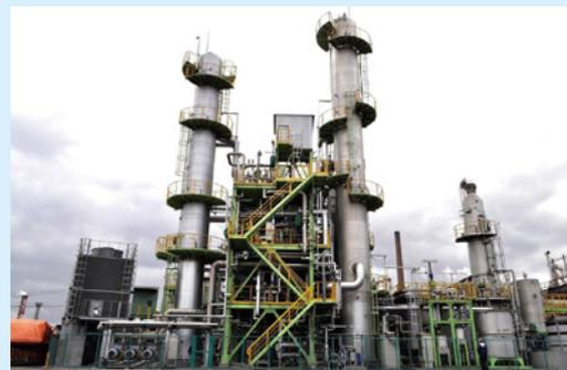
COURSE50のCO<sub>2</sub>分離・回収技術を元に産業用途に商品化したプロセスがESCAP®(Energy Saving CO<sub>2</sub> Absorption Process)であり、炭酸ガスやドライアイスの製造が行われている。(ESCAP®は日鉄エンジニアリング(株)の登録商標)
