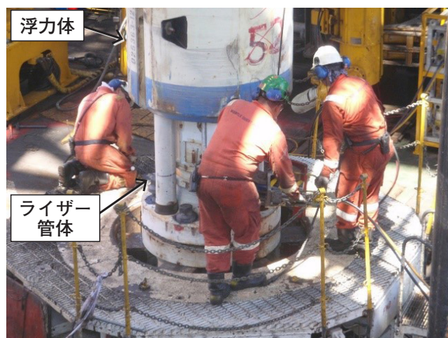
図8 ドリルフロアでのライザー接続作業
