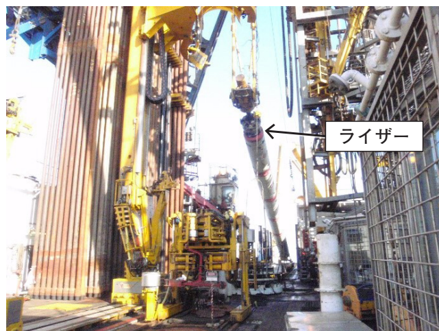
図7 ドリルフロア内でライザーを吊り上げる様子
