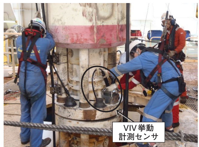
図10 VIV挙動計測センサの取り付け
