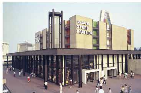
鉄鋼館 恒久施設として建設された鉄鋼館。耐候性鋼が多用されているのが特徴で、開口部周りの飾りや1階の野外の鉄骨柱に使用されている。
