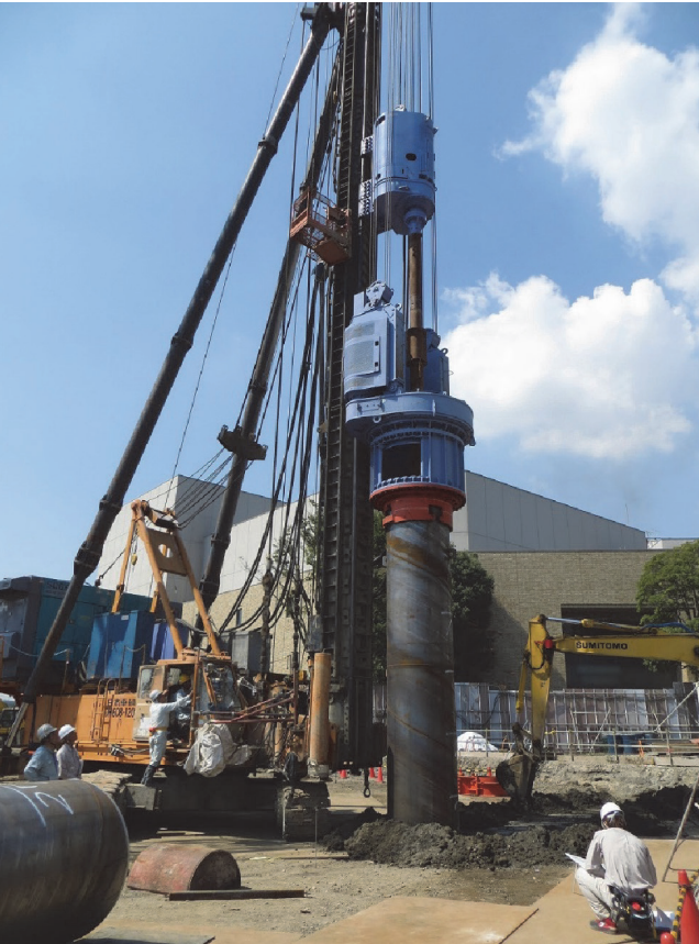
図5 JFE-HT590Pの施工風景
