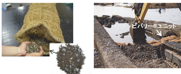
図10 ビバリー®ユニット (左) と、泊村海岸での埋設状況 (右)
