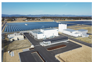
再生可能エネルギーを利用した世界最大級の水素製造施設「FH2R」完成 5) ※1スタックサイズで10MW＝世界最大規模 2000Nm 3 /h規模で、高稼働率と低電力化を目指す
