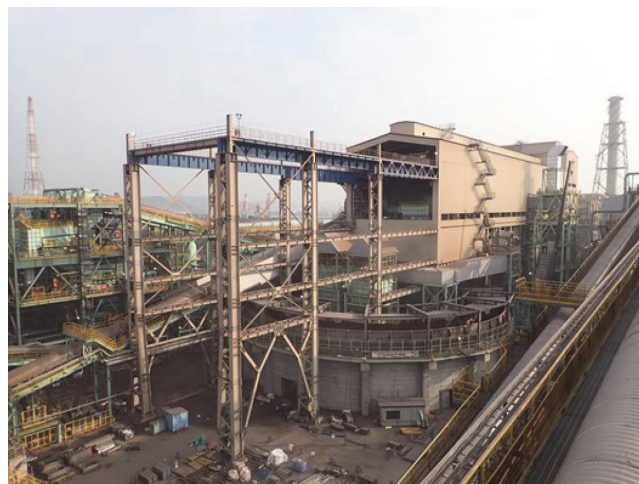
図2 福山No.3焼結機建設状況（全景）
