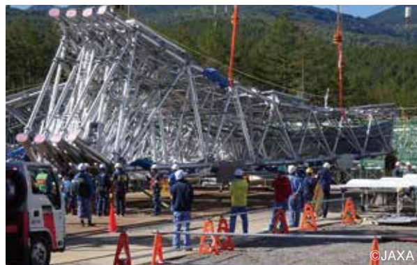
主反射鏡は10ブロックに分割して組み立てる。上部の鏡面パネルを下部の鋼製トラスが支える。トラスの外側には日よけカバーを取り付ける。
