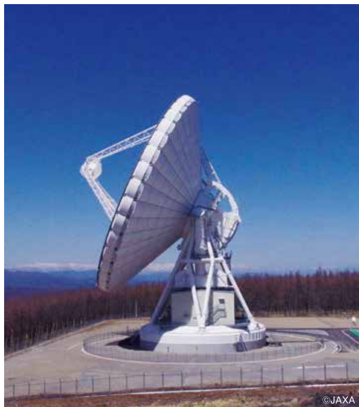
●総重量約2,200t、全高69m、主反射鏡直径54m ●周波数：X帯（8GHz）、Ka帯（32GHz） ●設計寿命：20年
