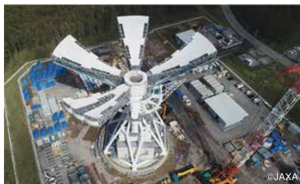
建設中の主反射鏡
