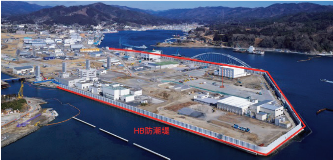
図6 HB防潮堤施工実績 (気仙沼港)
