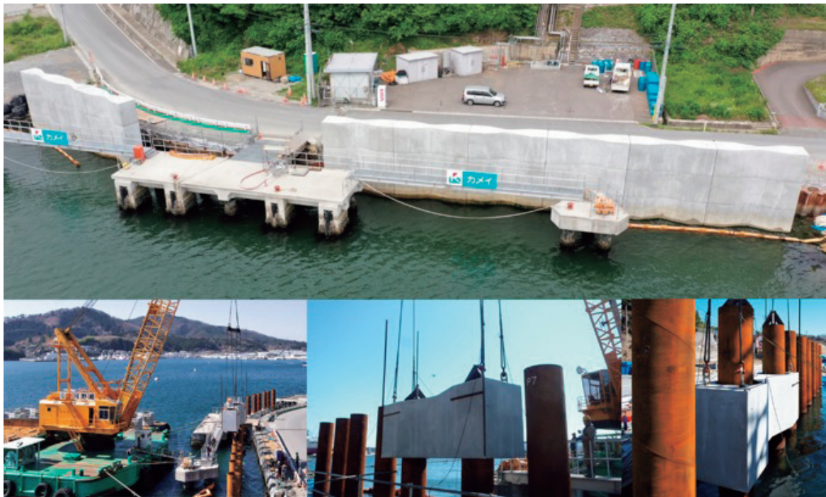
図7 宮城県気仙沼漁港大浦地区のハイブリッドタイプ（1列杭）
