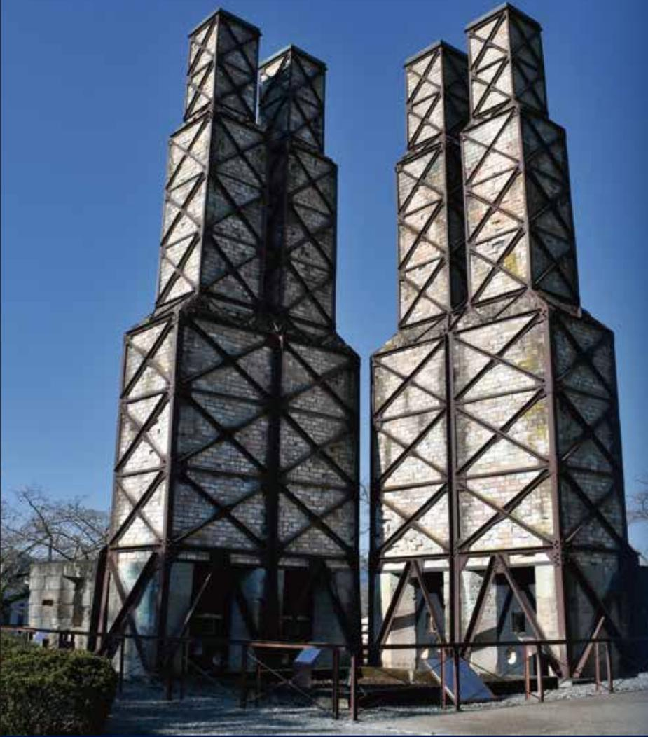
葦山反射炉(静岡県伊豆の国市)は、北側2炉と南側2炉の連双式2基4炉で構成される。高さは15.6m、底部面積5×6m。石製の基礎の上に建設されている。外側は伊豆石の組積造、内側は伊豆天城山産出の土で作られた耐火レンガのアーチ積である。(2021年10月29日まで反射炉本体補修工事中)
