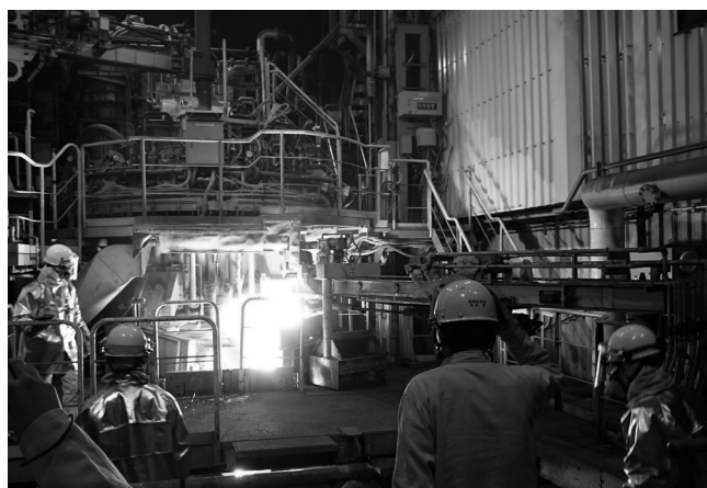
図6 出銑中のパイロット試験設備
