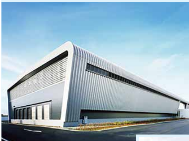
石狩データセンター 設計施工:大成建設(株)、所在地:北海道石狩市、敷地面積:51,448 m 2 、建物構造:地上2階建、鉄骨造。屋根および壁には、2枚のめっき鋼板に断熱材を挟んだ材料が使用された。一体成形により雨水の浸入を防ぎ、美しい曲面デザインを実現した。
