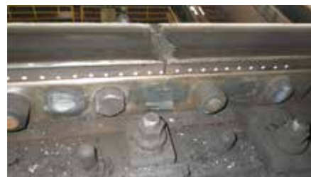
レール継目部の損傷状況
