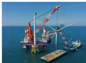
北九州で行った風車撤去作業の様子。SEP船は洋上風力発電設備の建設だけでなく、維持管理や撤去にも必要になる。
