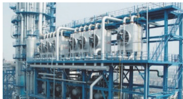
図10 石油精製設備用プレート式熱交換器の使用例 (Online version in color.)
