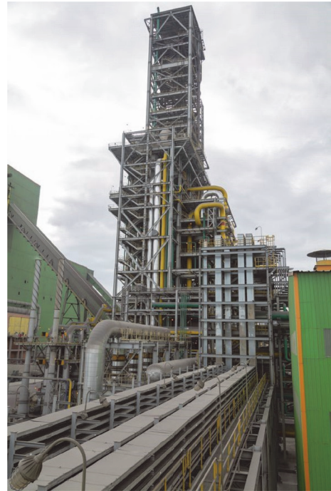
図5 アルジェリア・オランのトシアリ社の製鉄所に建設された最新MIDREX NGプラント (還元シャフト炉 (奥中央) と製鋼工場 (奥左側) にHDRIを搬送するコンベア (手前)) (Online version in color.)
