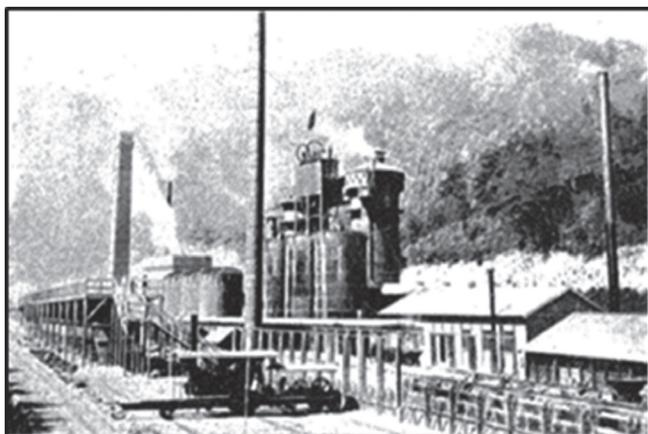
図3 釜石鉱山田中製鉄所25t高炉及びコペー式コークス炉
